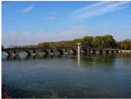
Figure 20. Tunca Köprüsü (Ekmekçizade Ahmet Paşa Köprüsü), Edirne, Turkey (1615)
